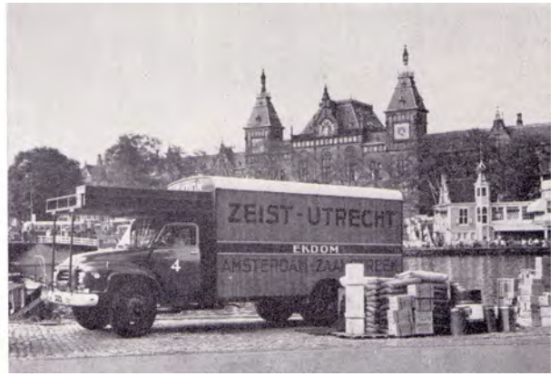
Boven: deze opbouw – deels uitgevoerd met houten panelen – maakt maximaal gebruik van de belastbare capaciteit. Deze bodewagen is een bekend gezicht in veel Nederlandse steden.
